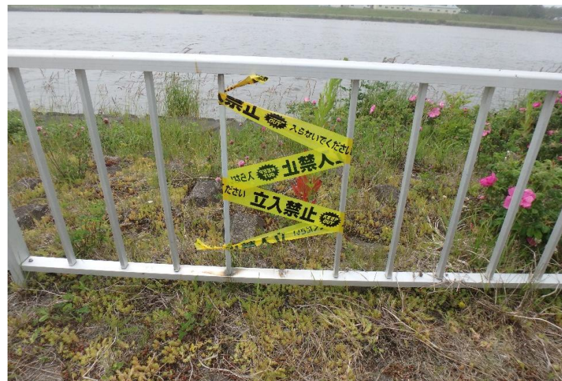
応急処置・立入禁止テープ設置
