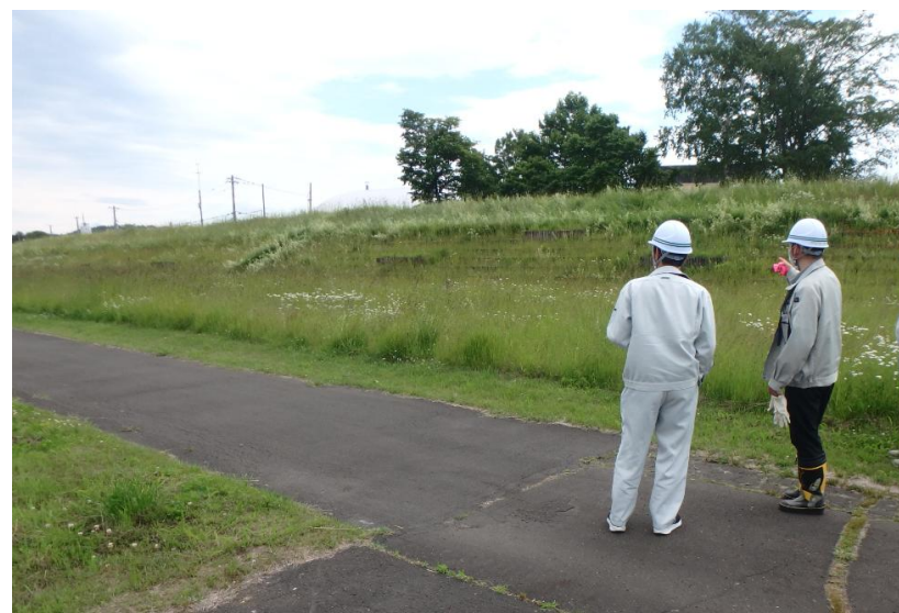
点検実施状況
