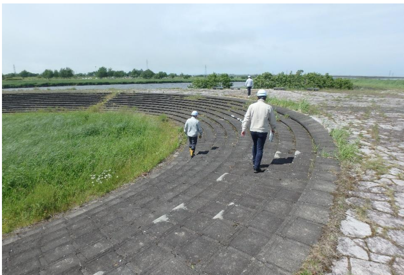
点検実施状況
