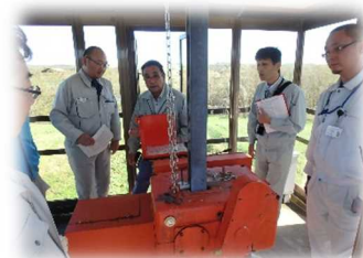
樋門操作の確認の様子
