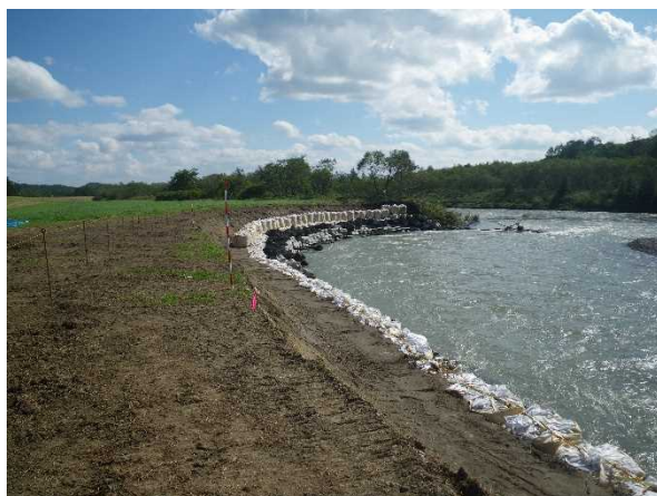
河岸侵食を受けた箇所
