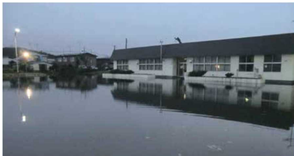
冠水により浸水寸前の標茶町勤労者
