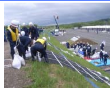
シートを張って堤防を守る工法
