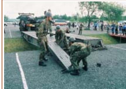
落橋した箇所に仮設橋を架けます
