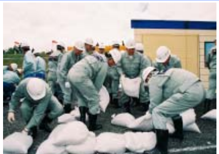
土のうを積み家屋への浸水を防ぎます
