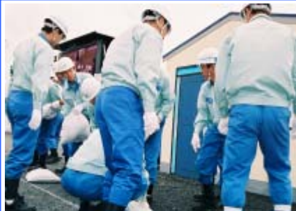
土のうを積み家屋への浸水を防ぎます
