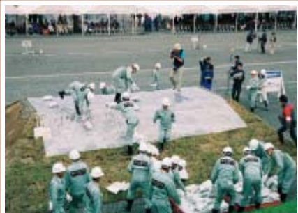
堤防に出来た亀裂の応急復旧工法
