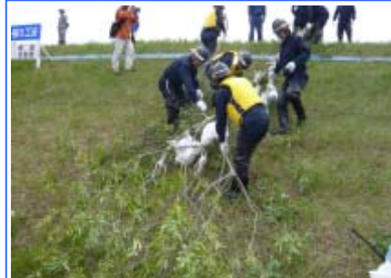
木で水の流れを弱めるための工法
