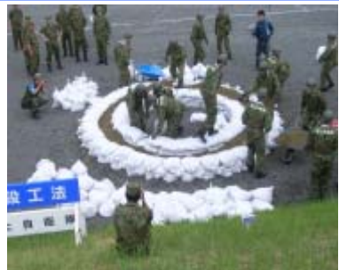
自衛隊による釜段工法
