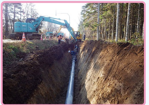
根室地区 用水路
