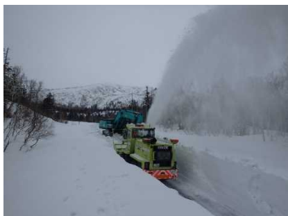
ロータリ除雪車による作業状況
