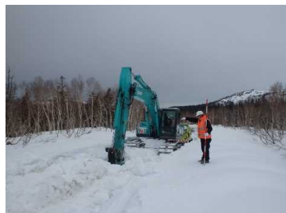
油圧ショベルによる作業状況
