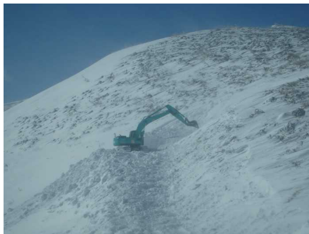
油圧ショベルによる斜面除雪
