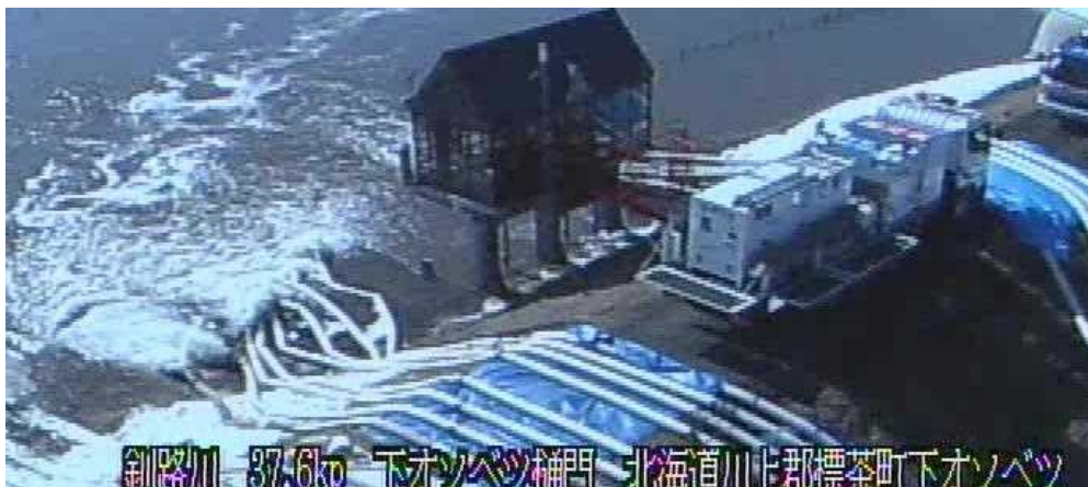
排水ポンプ車による内水排除活動(下オソベツ樋門)
