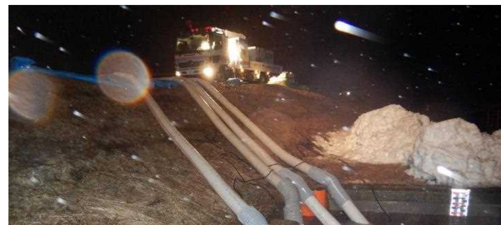
照明車の活動による夜間の排水活動(下オソベツ樋門)
