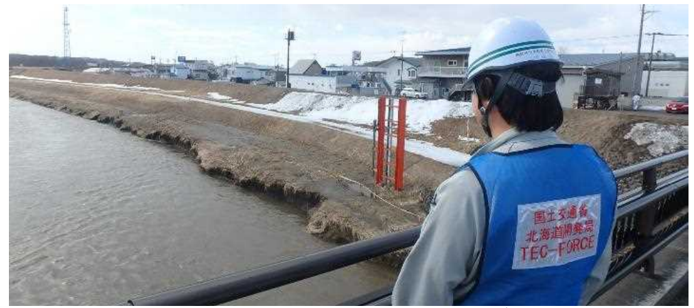
河川管理施設の点検(標茶町開運橋)
