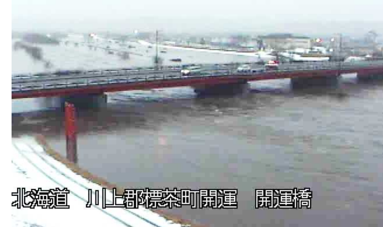
標茶水位観測所(KP46.1付近)の状況 令和2年3月11日 6時30分 最高水位時
