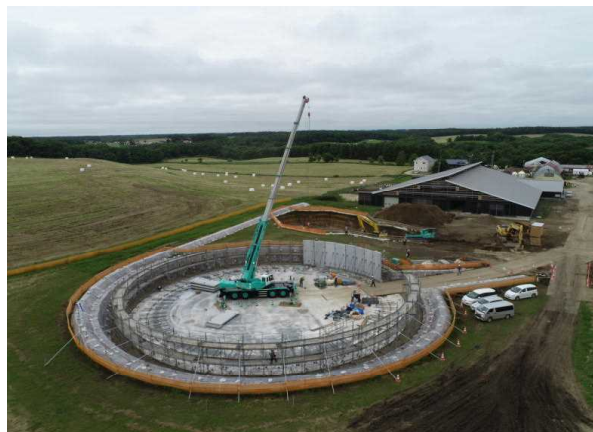
施工中の肥培かんがい施設（別海北部地区）
