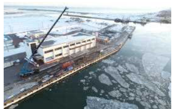
大津地区 係留施設整備状況
