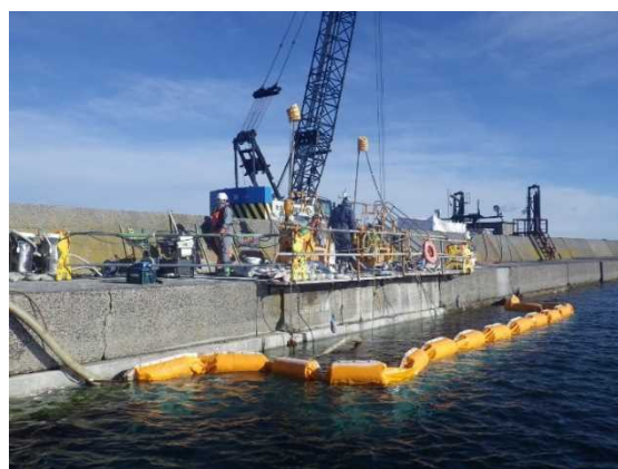
キリタツブ 霧多布港本港地区 北防波堤改良状況
