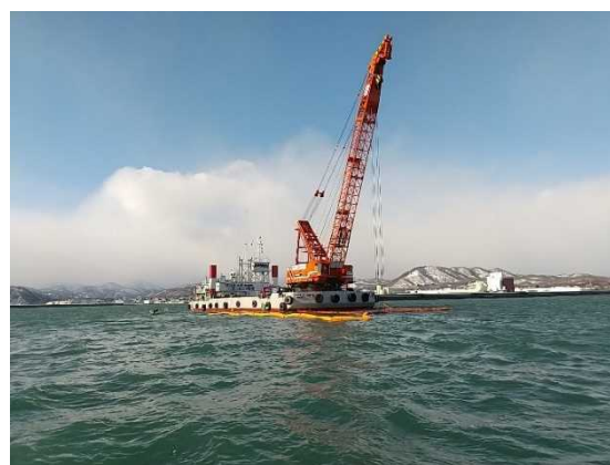
十勝港本港地区 航路浚渫 シュンセツ 状況
