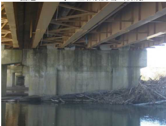
耐震補強（対策前）
