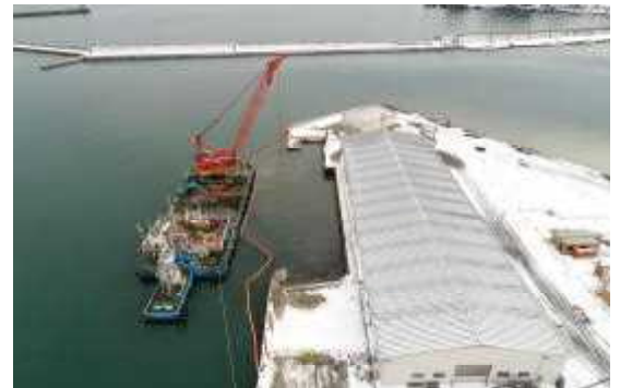
落石地区 係留施設整備状況
