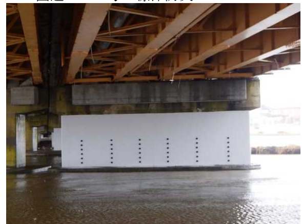
耐震補強（対策完了）
