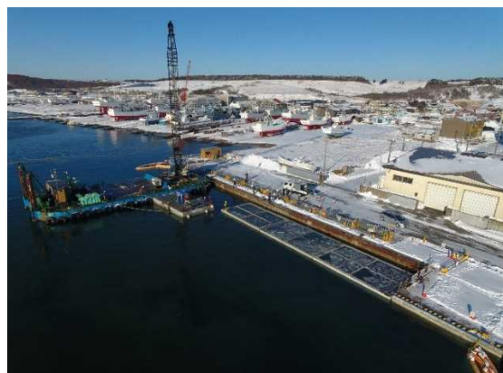
ハナサキ 根室港花咲地区 屋根付き岸壁整備状況
