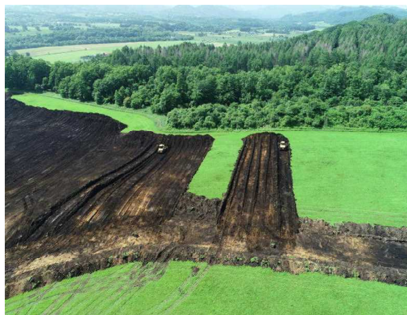
区画整理工事
