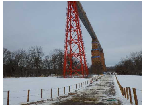
釧路空港 進入灯橋梁改良状況
