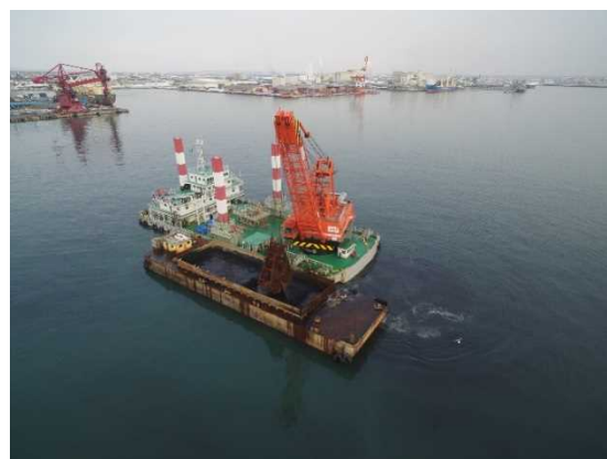
釧路港西港区 泊地整備状況
