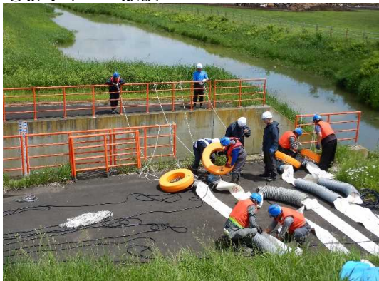
③排水ポンプ敷設
