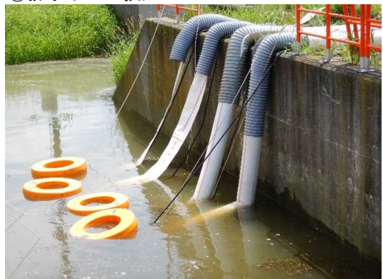
④排水ポンプ投入
