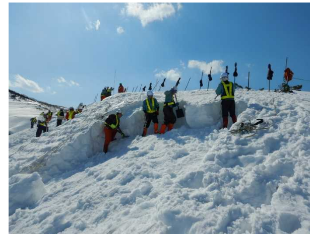
人力による雪庇処理、斜面除雪
