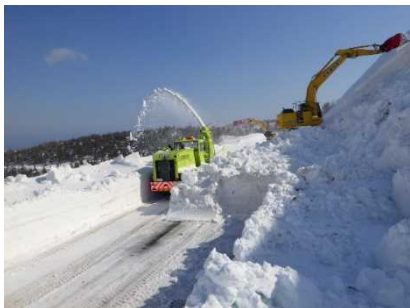
ロータリ除雪車による作業状況
