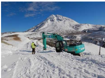
油圧ショベルによる作業状況
