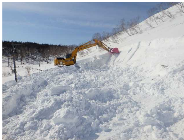
油圧ショベルによる斜面除雪
