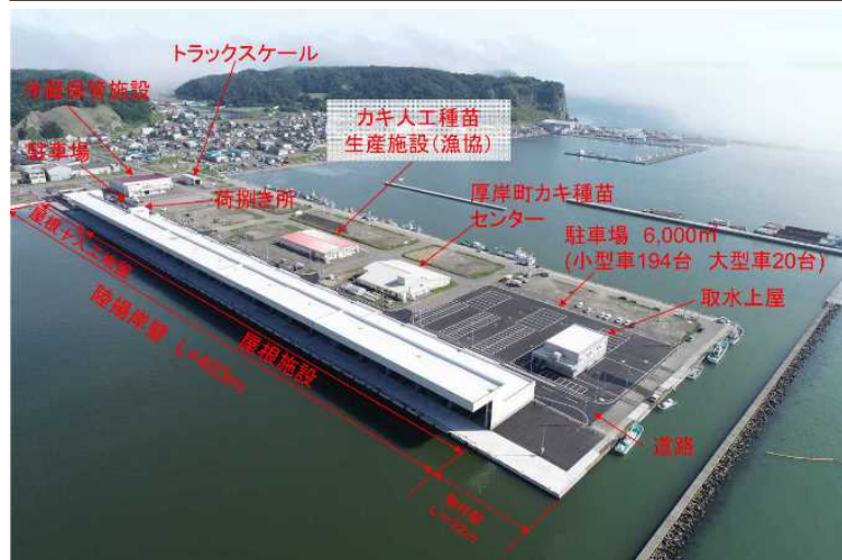
湖南地区第2埠頭に整備した衛生管理施設(全景)
