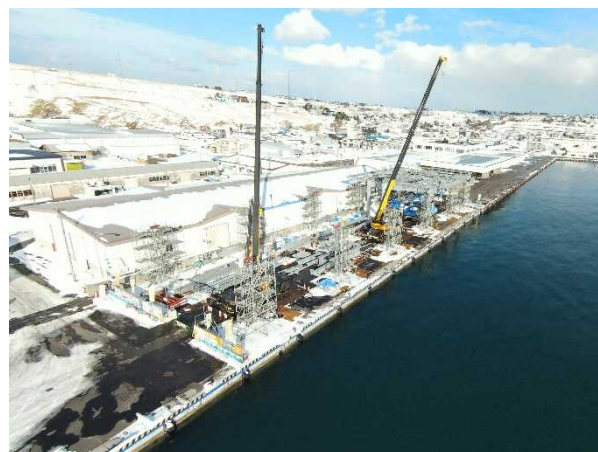
根室港花咲港区 屋根付き岸壁整備状況
