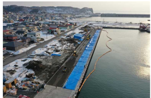
岸壁補修状況
