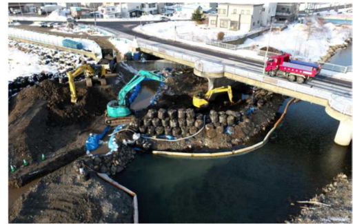
橋梁補修状況
