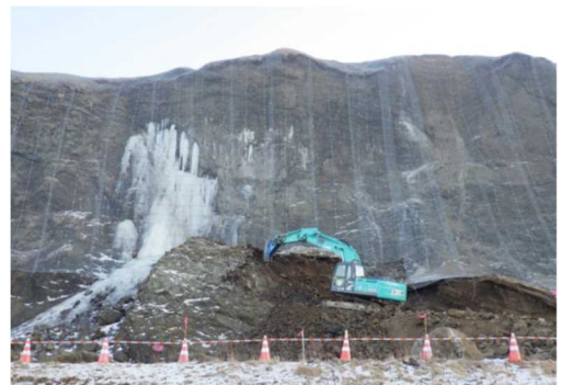
崩落土砂撤去(無人化)施工状況
