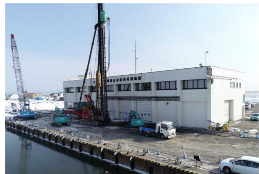
屋根付き岸壁整備状況
