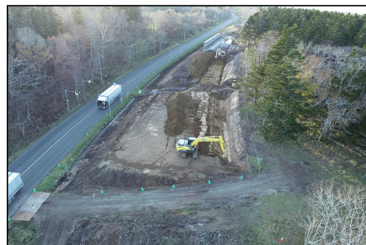
国道44号 根室防雪
