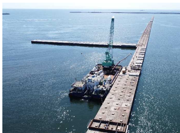
釧路港西港区 新西防波堤整備状況
