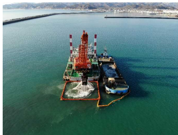
十勝港本港地区 航路浚渫 シユンセツ 状況
