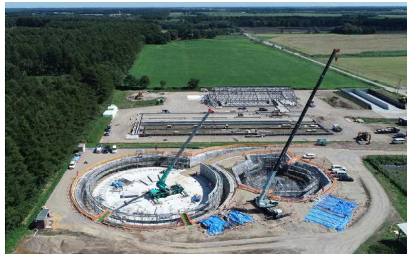
施工中の肥培かんがい施設（別海北部地区）
