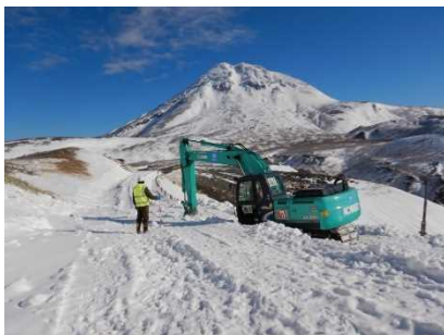
油圧ショベルによる作業状況
