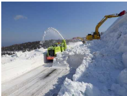
ロータリ除雪車による作業状況
