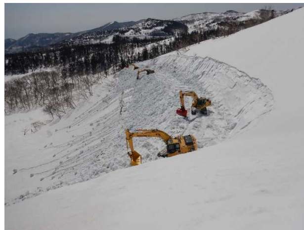
油圧ショベルによる斜面除雪
