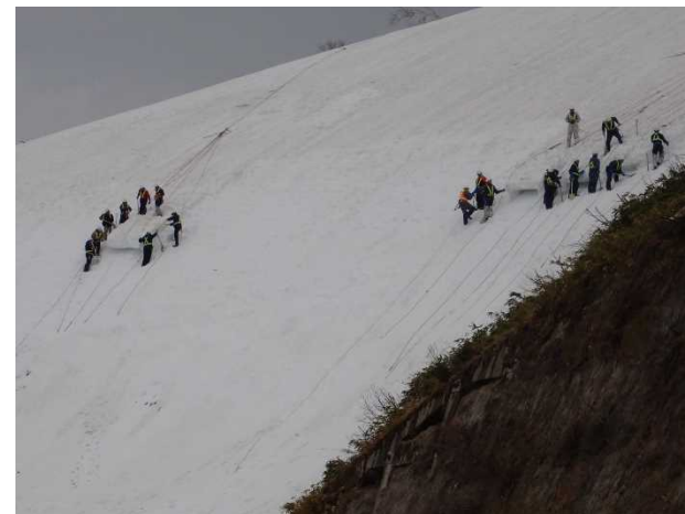
人力による雪庇処理、斜面除雪
