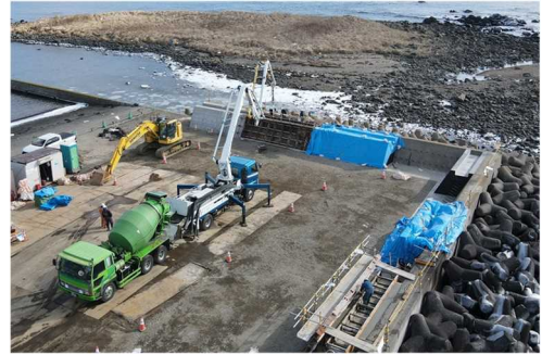
護岸嵩上げ整備状況
