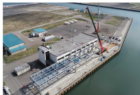
屋根付き岸壁整備状況
