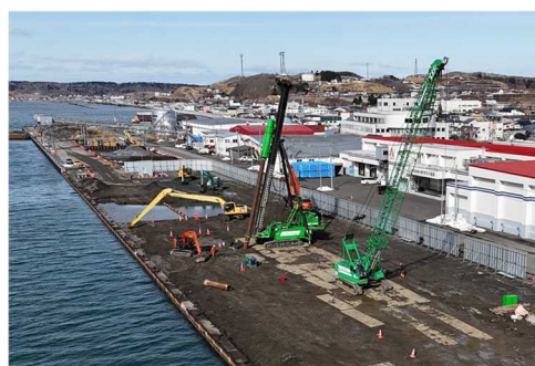
岸壁嵩上げ整備状況
