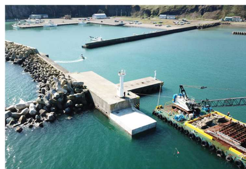
防波堤整備状況
