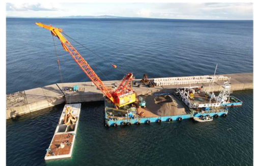
防波堤整備状況
