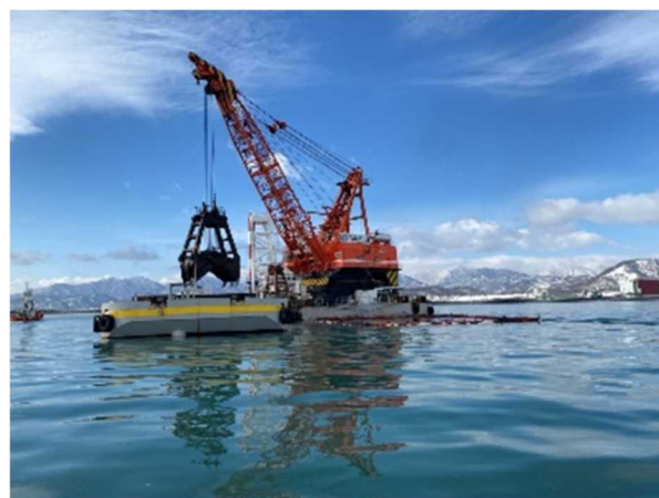
十勝港本港地区 航路 シュンセツ 浚渫状況
