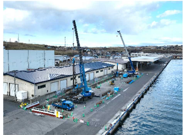
根室港 ハナサキ 花咲港区 屋根付き岸壁整備状況
