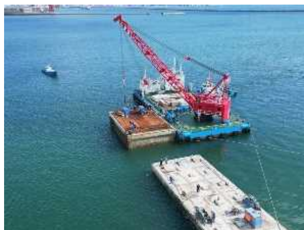
釧路港西港区 土砂処分場整備状況
