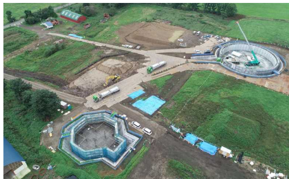
施工中の肥培かんがい施設（別海北部地区）
