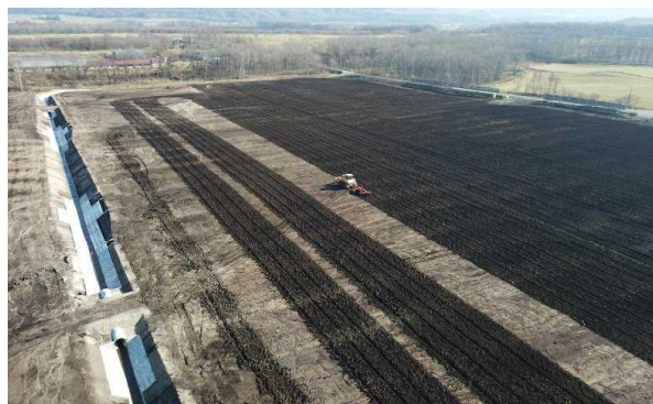
区画整理施工状況（阿寒地区）
