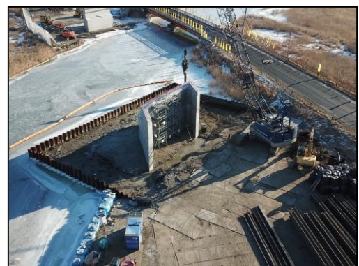
国道44号 根室防雪 (別当賀橋下部工建設)
