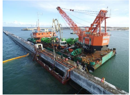
防波堤整備状況
