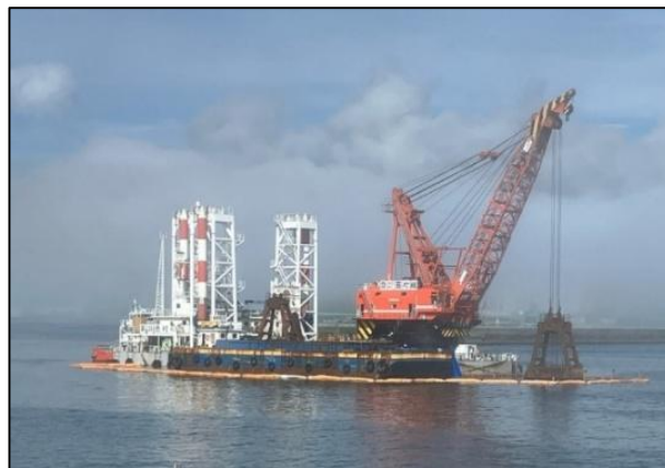
十勝港本港地区 航路浚渫 シユンセツ 状況
