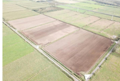
区画整理基盤整備状況（阿寒地区）
