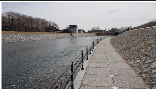
釧路川の河道整備状況（掘削、護岸）
