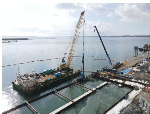
岸壁嵩上げ整備状況
