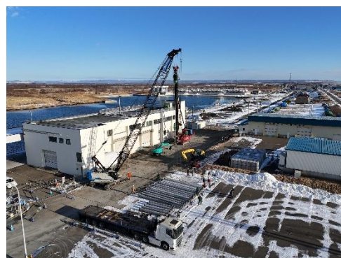
道路(屋根)整備状況
