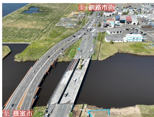
国道 44 号 雪裡橋架替
