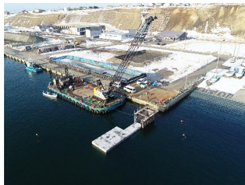
岸壁整備状況
