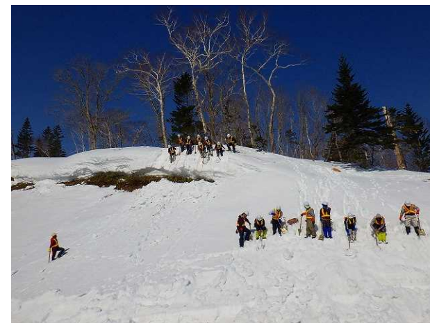
人力による雪庇処理、斜面除雪
