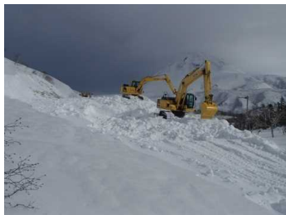
油圧ショベルによる作業状況
