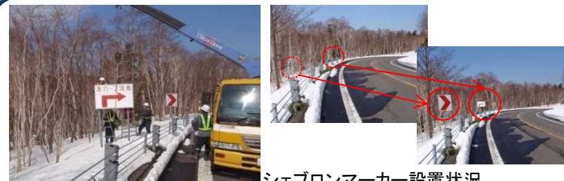
シェブロンマーカ―設置状況
