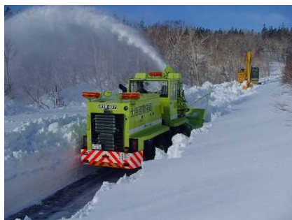
ロータリ除雪車による作業状況
