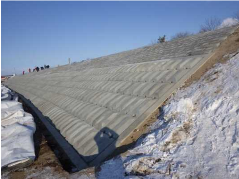
災害復旧工事完了
