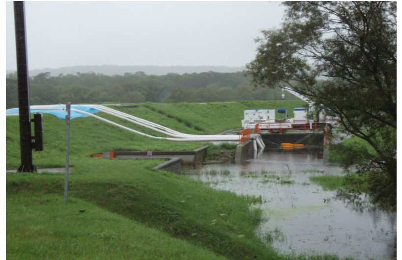
標茶町下オソベツ樋門（排水ポンプ車内水吸引作業）
