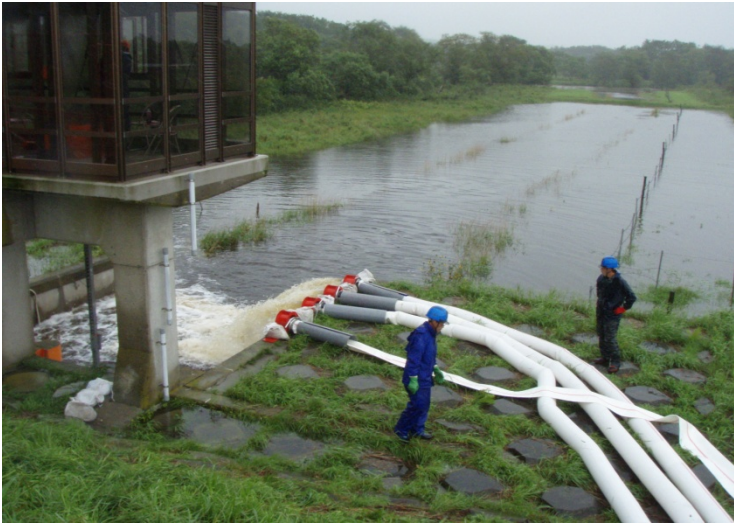
標茶町下オソベツ樋門（排水ポンプ車内水出水作業）
