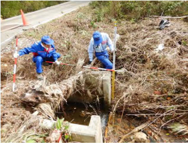
被災状況調査班（河川）
