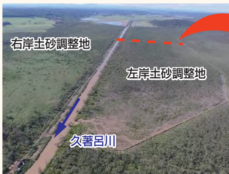
久著呂川の土砂調整地
