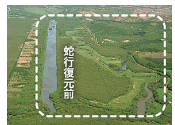
↓直線部分を埋め戻し
