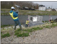
R7.5 堤防点検状況
