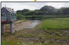
R7.7 釧路川 旭第一樋門
