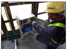
R7.5 新釧路川 昭和樋門
