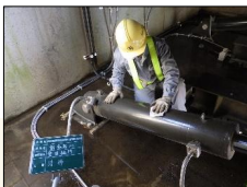
R7.5 新釧路川 愛国樋門
