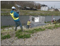
R7.5 堤防点検状況
