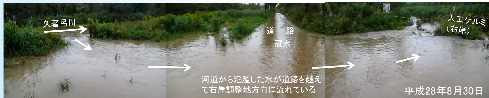
写真②: 河道から右岸側への氾濫の様子
