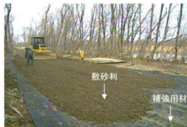
図 3-10 （例）現況地盤圧密の軽減対策
