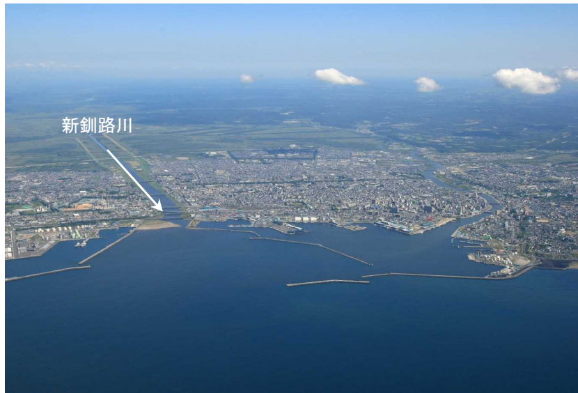
低平地で氾濫水が拡散しやすい 下流域(釧路市、釧路町)
