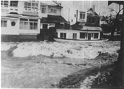
S35弟子屈町 浸水状況
