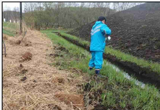
土砂溜溝の確認
