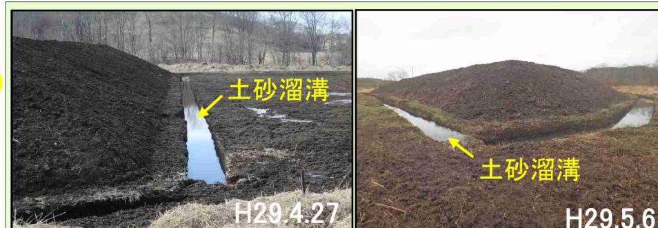
設置した土砂溜溝
