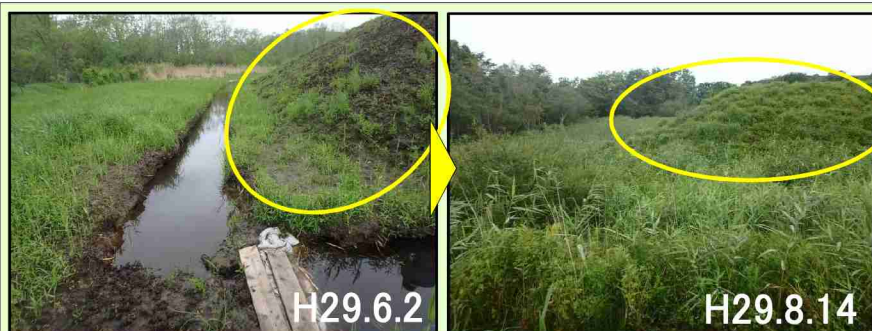
法面緑化後の様子
