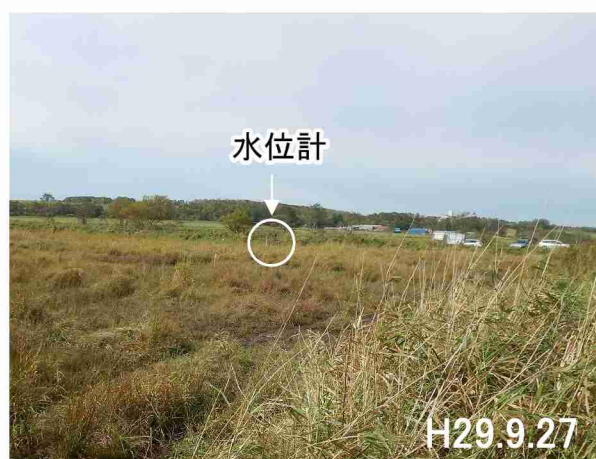
水位計設置地点周辺の様子
