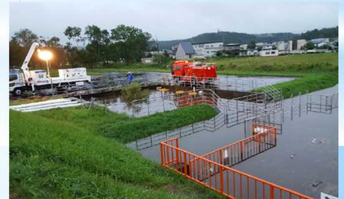
⑤ 増水したオモチャリ川の氾濫を防ぐためポンプ車による排水作業(21日午後6時)
