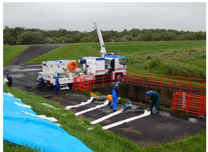
災害対策用機械による排水準備
