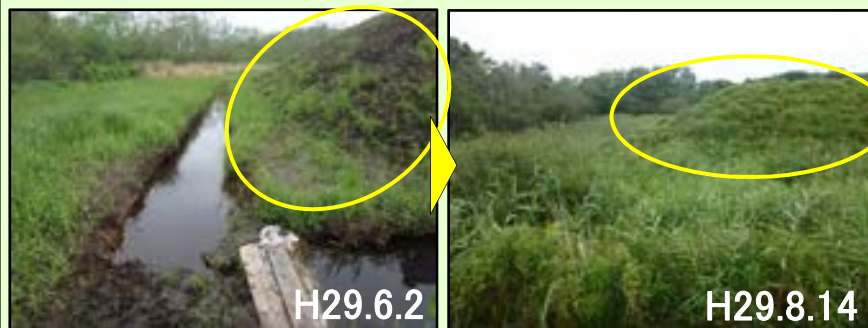
法面緑化後の様子
