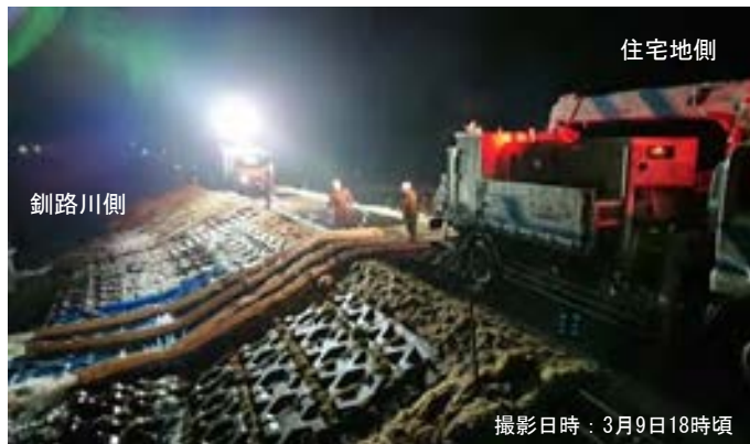
照明車の活動による夜間の排水活動(標茶町市街地)
