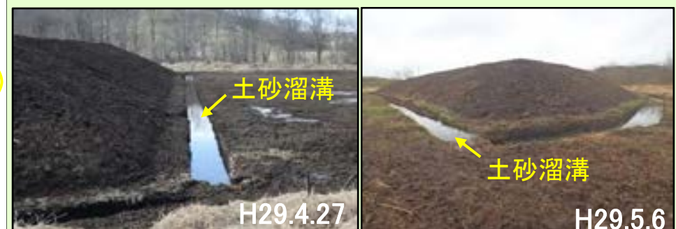
設置した土砂溜溝
