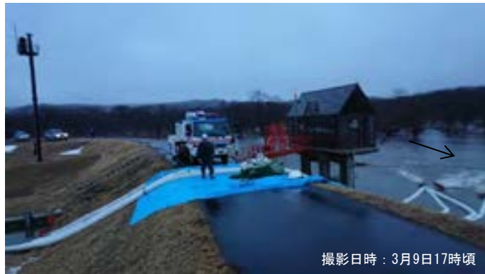
排水ポンプ車による内水排除活動(下オソベツ)
