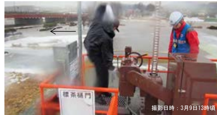
樋門施設等の確認(樋門操作時の状況)
