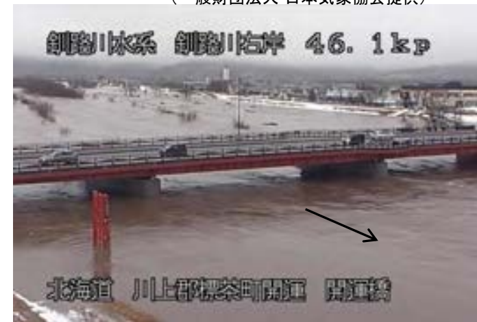
標茶水位観測所(KP46.1付近)の状況 平成30年3月9日 17時 最高水位時
