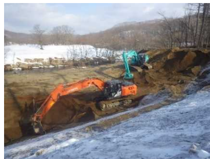
阿寒川における掘削状況
