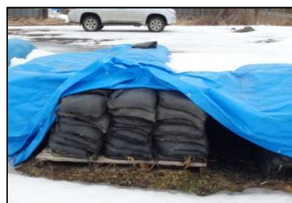
土のう保管状況
