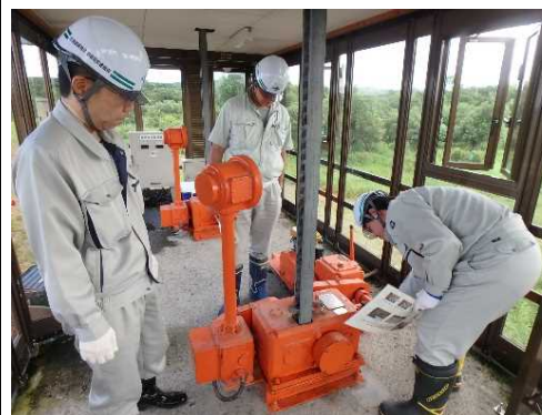
樋門操作訓練
