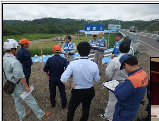
重要水防箇所の共同点検
