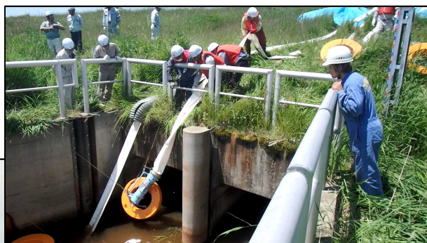
排水ポンプ車・排水管の設置訓練
