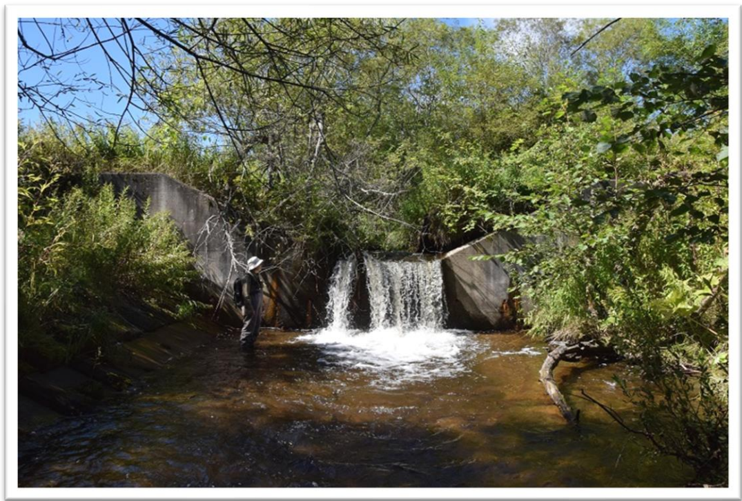
写真8. 魚道整備をおこなうイトウ、サクラマス、サケの遡上障害となっている落差工の一つ
