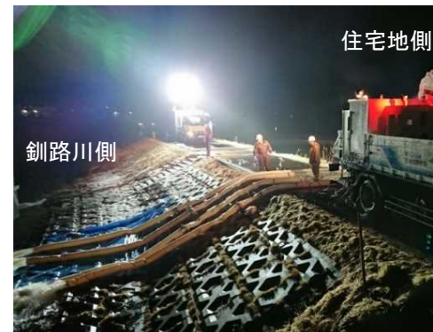
排水ポンプ車による排水活動
