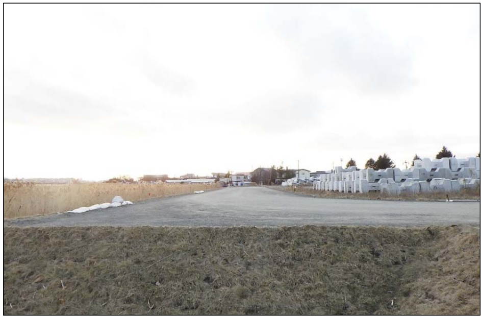
防災資材備蓄整備施設の整備状況
