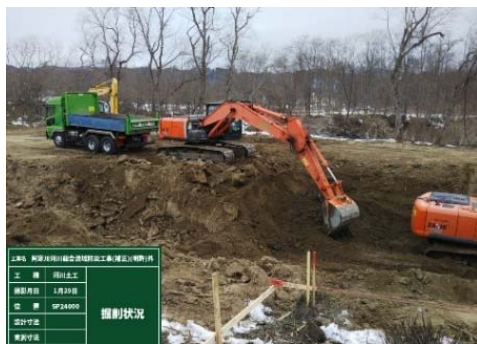
阿寒川における掘削状況
