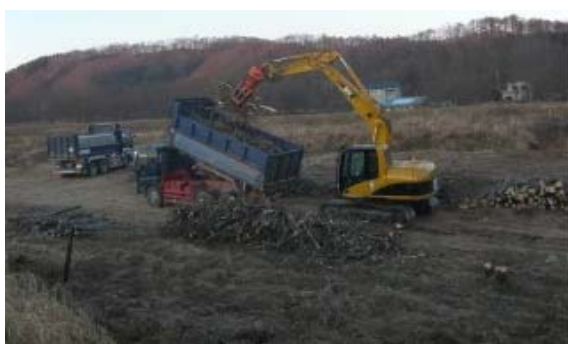
和天別川における河道内樹木の伐採状況
