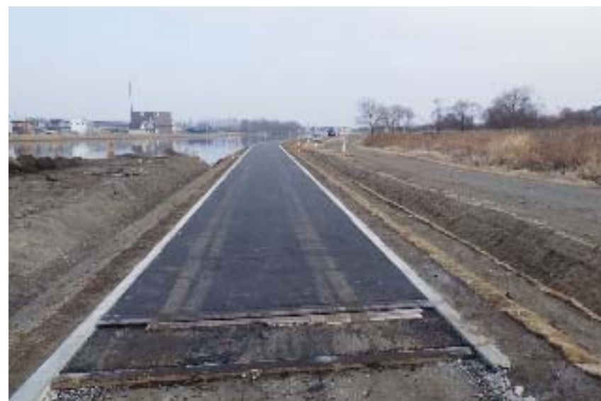
釧路川の堤防天端舗装の状況
