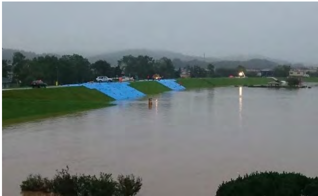
堤防法面の被災状況(標茶町)
