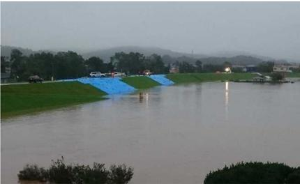
堤防法面の被災状況(標茶町)
