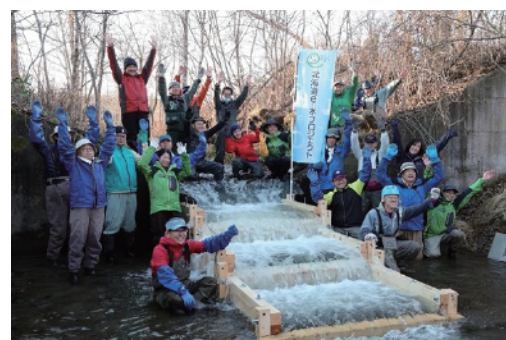
落差工への魚道整備を実施
