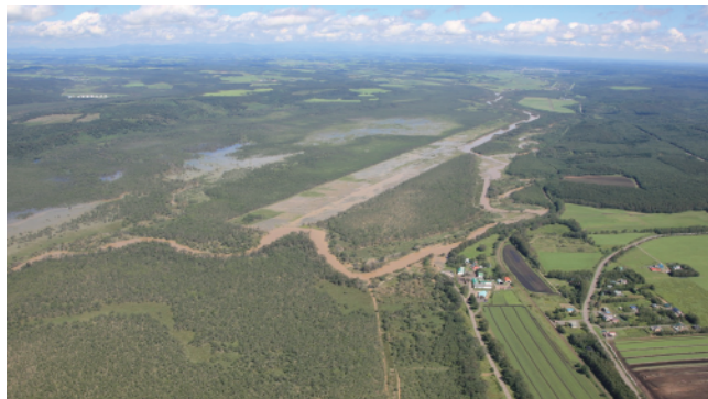
茅沼地区の全景 (H28. 8月出水時)
