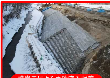
護岸工による土砂流入対策 (久著呂川: 釧路総合振興局)
