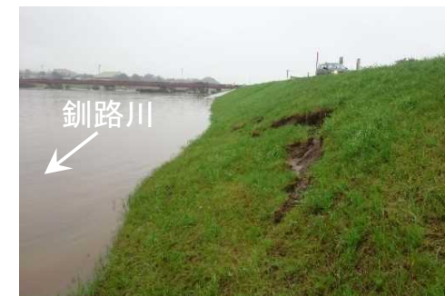
平成28年8月洪水の浸水状況と堤防ののり面の被災状況（標茶町）
