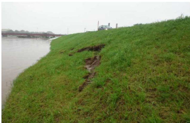
平成28年8月洪水における堤防ののり面の被災箇所の災害復旧（標茶地区）
