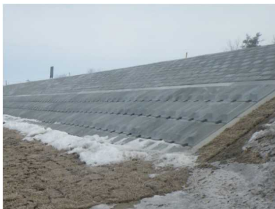
平成28年8月洪水における堤防ののり面の被災箇所の災害復旧（標茶地区）
