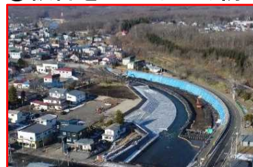
釧路川流域の市街地を守る河道掘削 (釧路開発建設部、釧路総合振興局) 機能強化(鶴居村内：釧路総合振興局)
