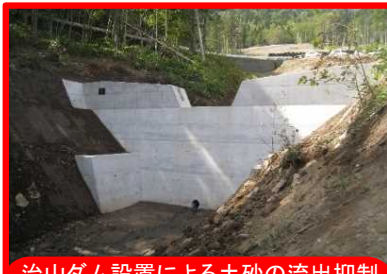
治山ダム設置による土砂の流出抑制 (弟子屈町内: 根釧西部森林管理署)
