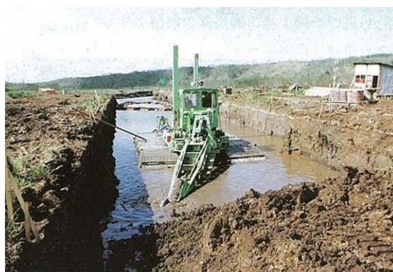
オソベツ川浚渫工事
