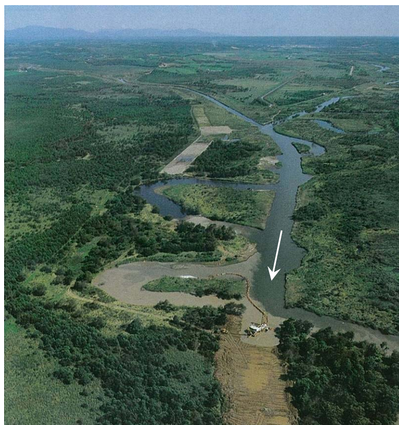
沼幌新水路浚渫工事
