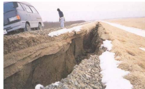
昭和 27 年 3 月 十勝沖地震の被害状況 (新釧路川左岸堤)
