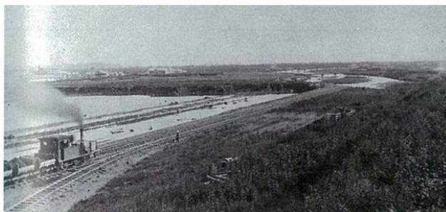
釧路川新水路工事風景(大正 12 年)
