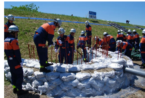
月の輪工、釜段工の設置
