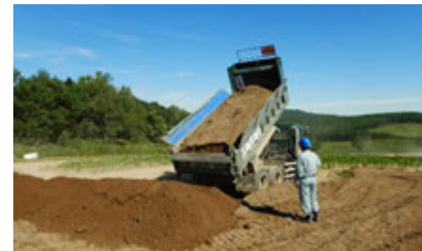
図6-1 河道掘削土の活用のイメージ図
