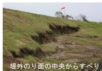
写真 2 - 4 平成28年8月の堤防被災状況
