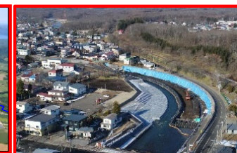
釧路川流域の市街地を守る河道掘削 (釧路開発建設部、釧路総合振興局)
