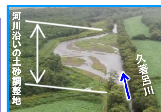
土砂流入対策：久著呂川、南標茶地域、雪理・幌呂地域（釧路開発建設部、釧路総合振興局、標茶町、鶴居村）
