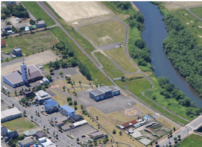
標茶河川防災ステーション
