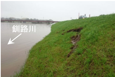
写真2-1 平成28年8月洪水の浸水状況と堤防ののり面の被災状況（標茶町）
