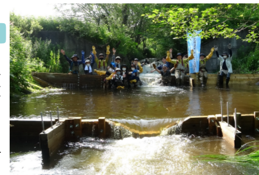
落差工への魚道整備を実施
