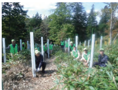
保護管被覆の様子
