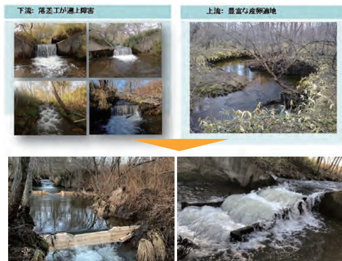
魚道整備後（2022年現在の状況）
