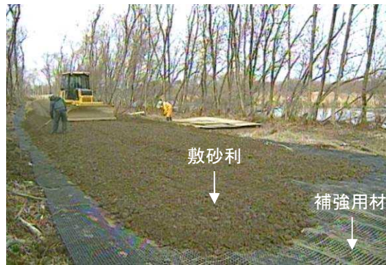
図 3-10 (例) 現況地盤圧密の軽減対策
