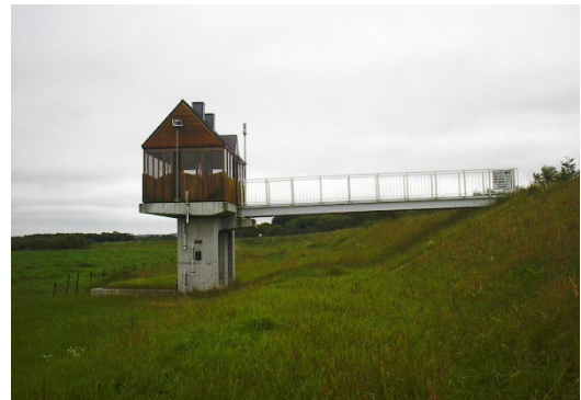
ルラン樋門上屋
