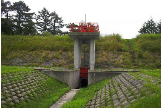
標茶終末処理場放流樋管
