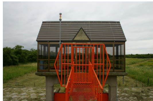
下オンベツ樋門上屋
