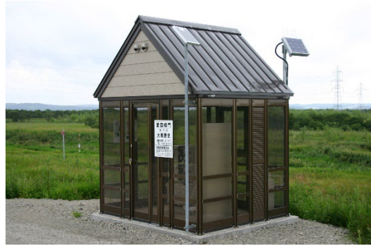
愛国樋門上屋
