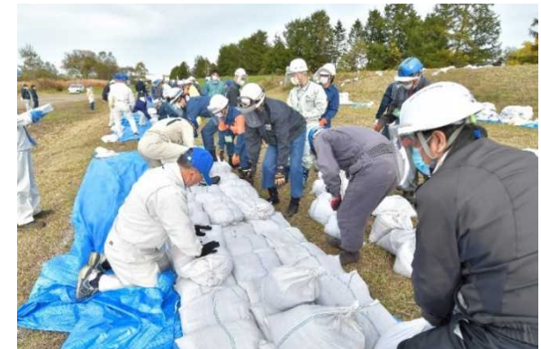
積み土のう工(杭省略型)実習
