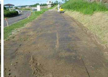
堤外側法尻の嵩上げ(川側へ傾斜)
