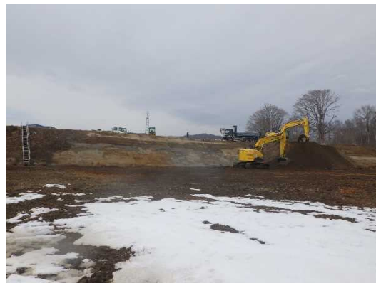
阿寒川における掘削状況
