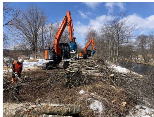
幌呂川における河道内樹木の伐採状況
