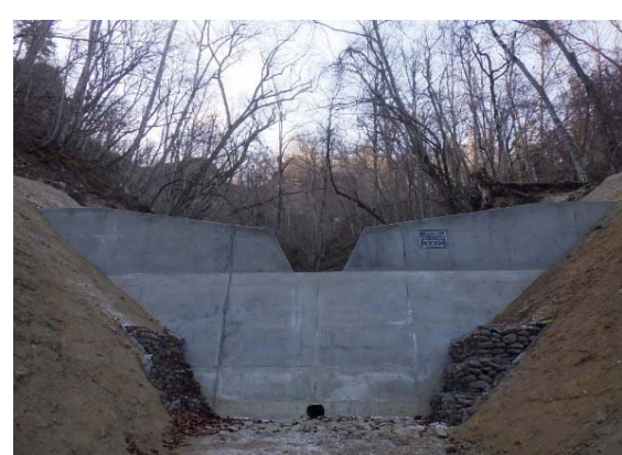
治山工事(溪間工)
