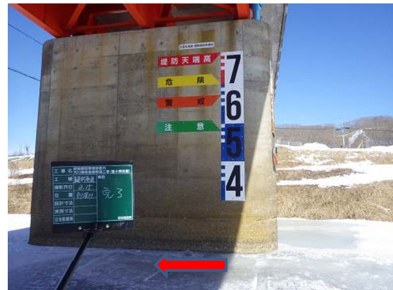
別保川(釧路町)に設置した量水標(令和5年度設置)
