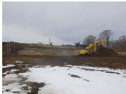
阿寒川における掘削状況
