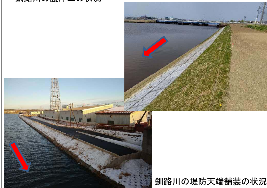
釧路川の護岸工の状況
