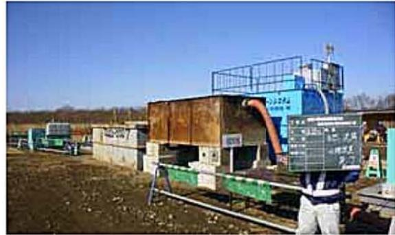
沈殿池・無機系凝集剤投入による濁水処理
