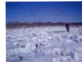
2-2. 伐採試験区1（施工後）
