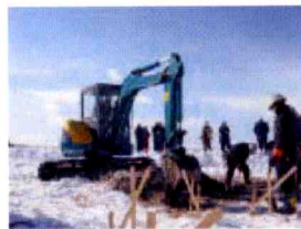
1-3. 小型バックホーによる剥ぎ取り
