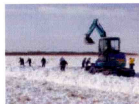
1-2. 人力によるアイスブリッジの施工
