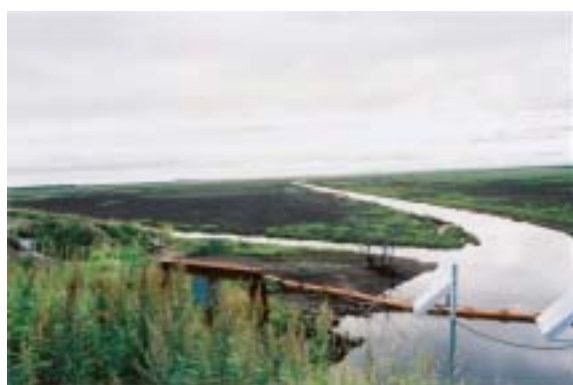
写真 3-3-1 放水後の湛水試験地の状況 (H15.9月撮影)
